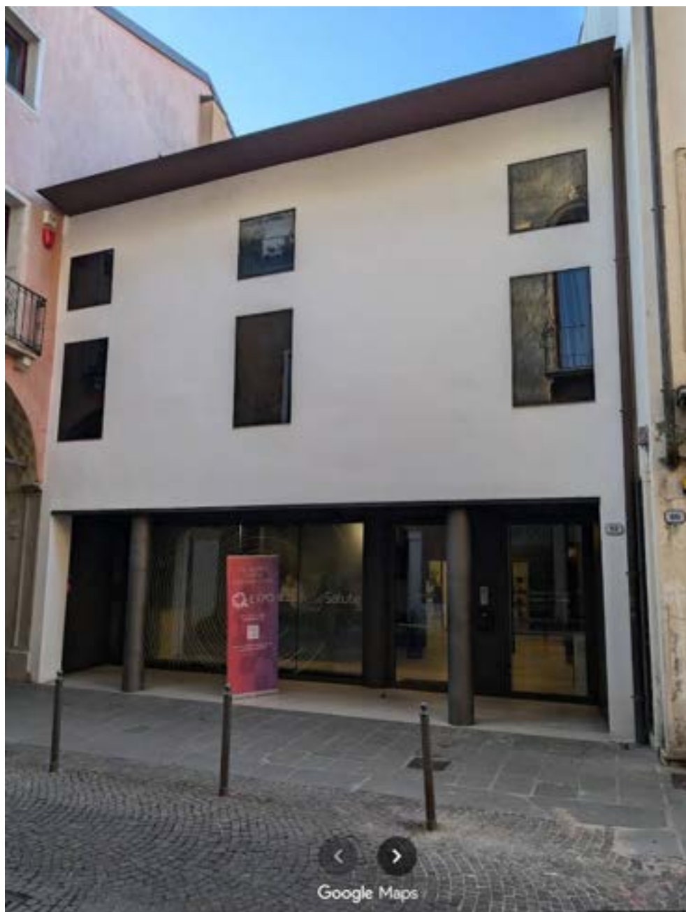
Main entrance to Palazzo della Salute, Via San Francesco 90.
